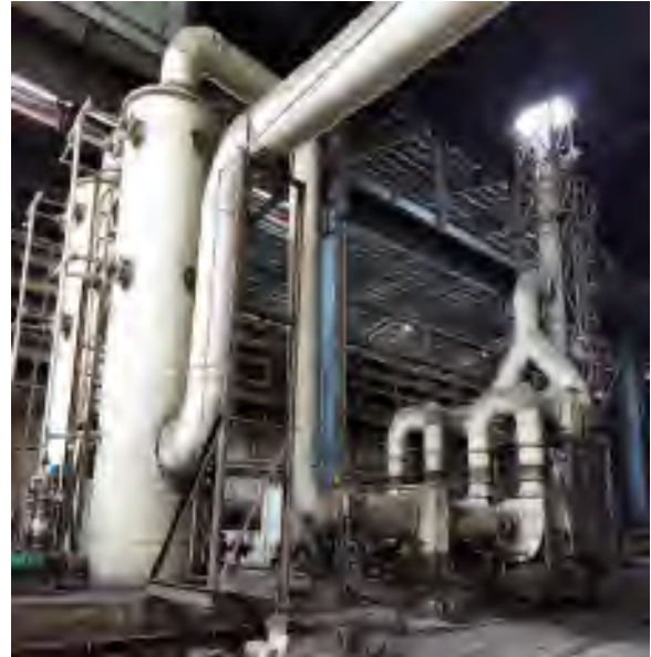
固溶酸洗 4#硫酸酸雾处理系统
