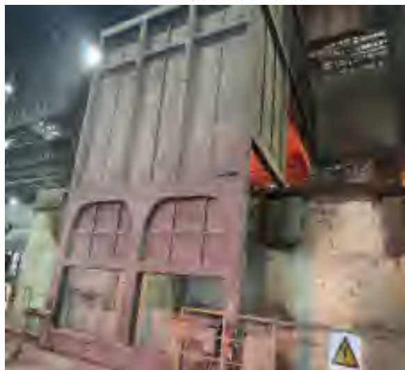
30t 合金熔化炉
