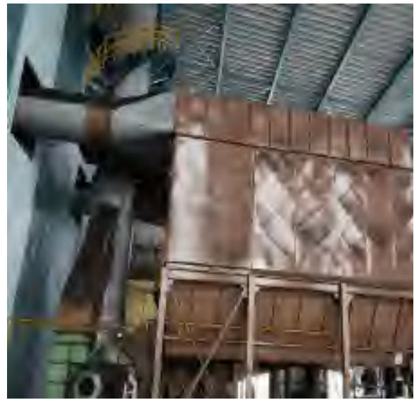
黑卷抛丸除尘废气处理系统
