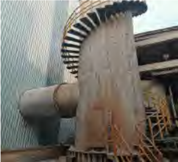
黑卷退火炉废气处理系统
