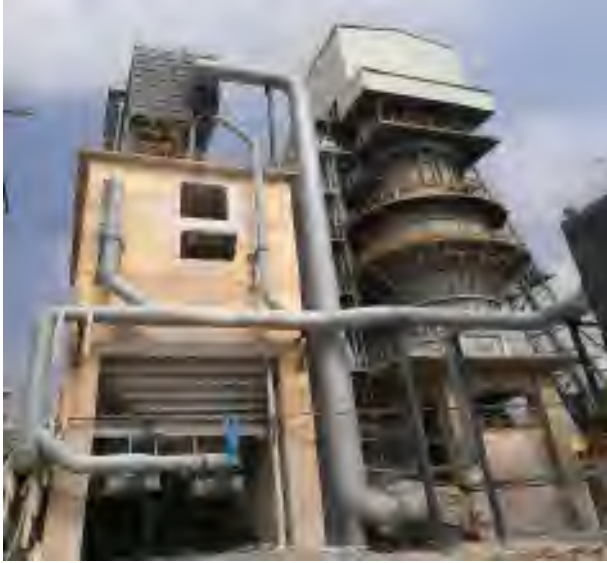
石灰窑除尘器
