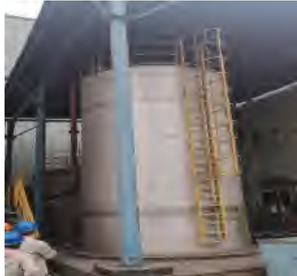
DRAPL 线混酸事故收集罐
