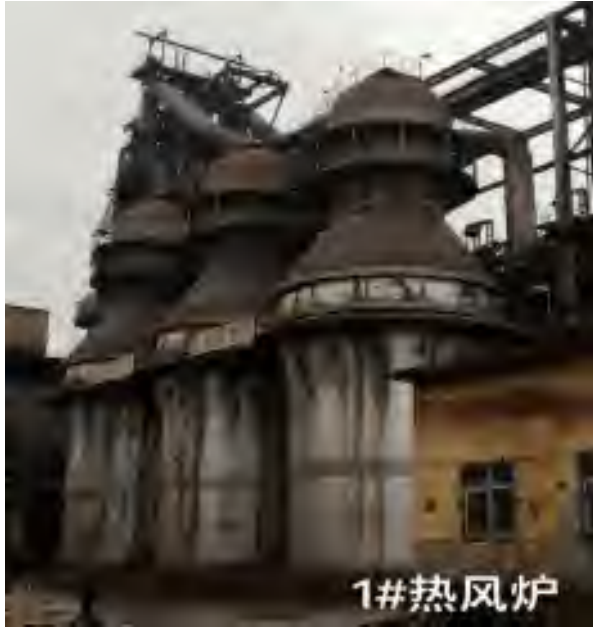
1# 600m 3 高炉配套热风炉
