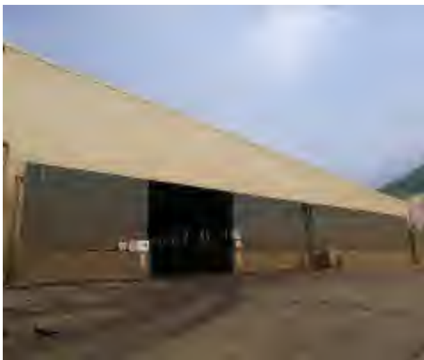
原料大棚半封闭式料场
