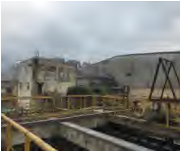
全厂西区污水处理站
