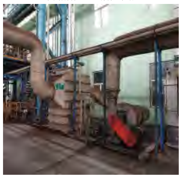
DRAP 脱脂废气处理系统
