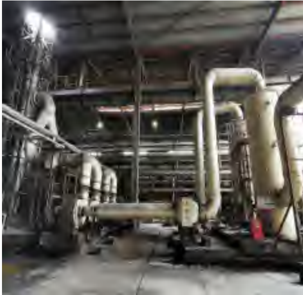
固溶酸洗 2#、3#硫酸酸雾处理系统
