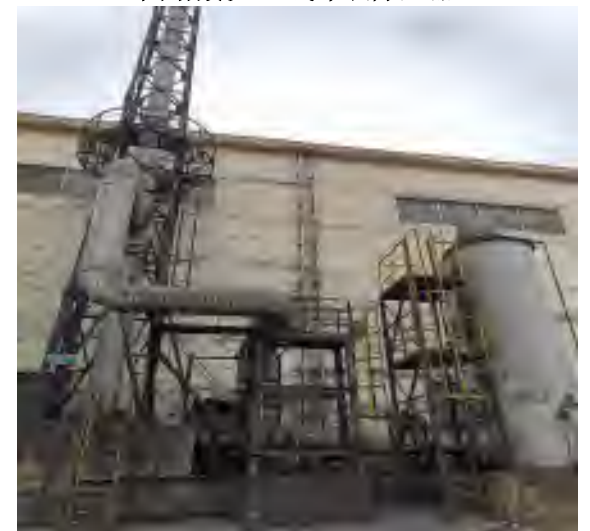
固溶酸洗 1#硫酸酸雾处理系统
