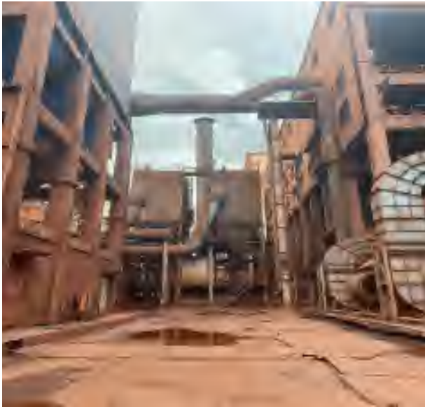
1#、2#烧结配料室除尘系统
