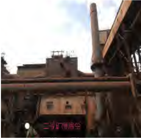
炼铁 2#矿槽除尘系统
