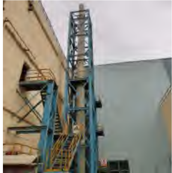
黑卷硫酸酸雾处理系统排气筒
