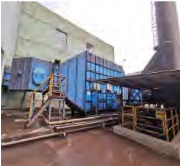
DRAP 轧机废气处理系统
