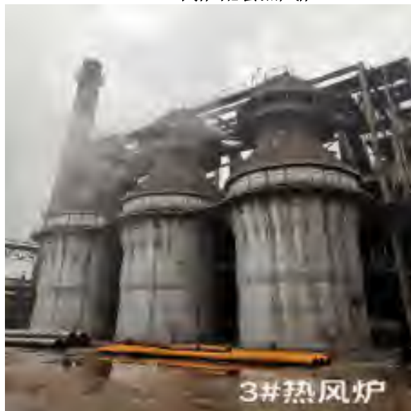
3# 600m 3 高炉配套热风炉
