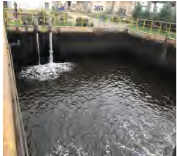
污水站调节池
