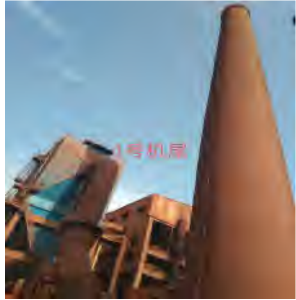
1#烧结机机尾除尘系统
