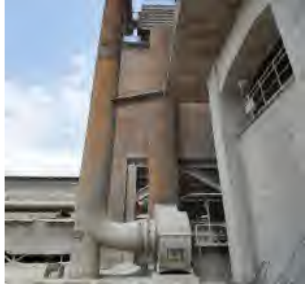
石灰窑除尘器
